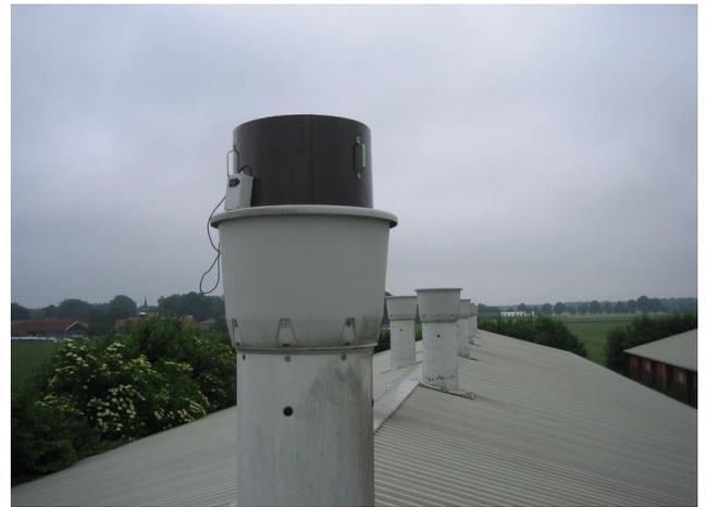
**Bild 2:** Messventilator im Abluftkamin
