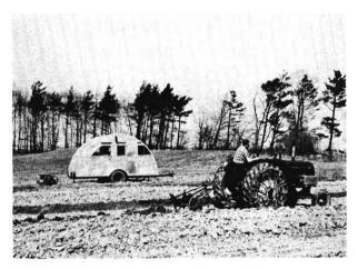
Bild 2. Versuchsschlepper beim Pflügen. Der Messwertsender ist über dem rechten Vorderrad montiert. Im Hintergrund sieht man die fahrbare Registrier- und Auswertestation mit Stromversorgungsaggregat.
