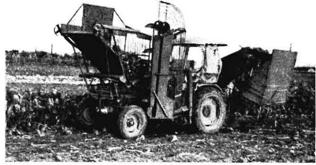
**Bild 13.** Deutscher Geräteträger mit Aufbau-Bunkerköpfröder (Fendt).
