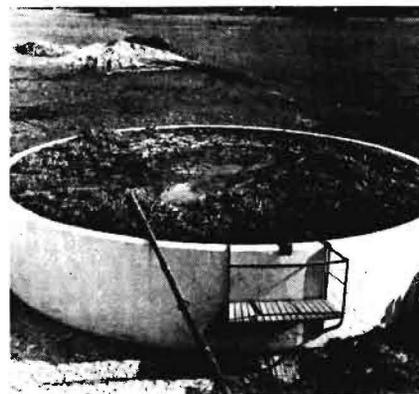
Bild 11 (rechts): Unzerstörte Schwimmschicht
