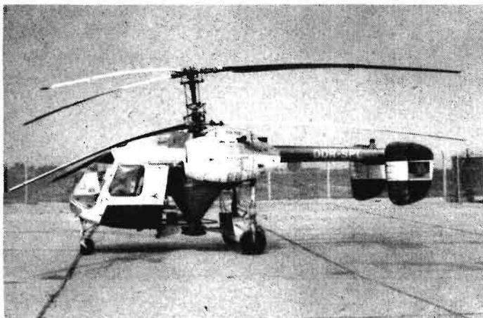
Bild 2. Schleuderradstreuanlage am Ka-26 mit Leit- und Abweiserblechen (Fotos: ZPL)
