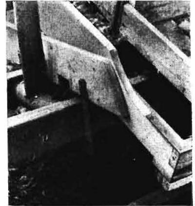
Bild 5. Anbringung des Aufsatzkastens am seitlichen Rahmenteil
