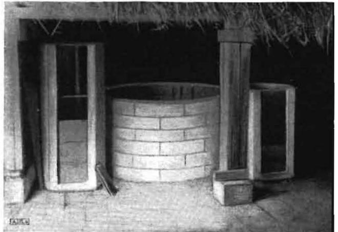
**Bild 4** Zwei Gärkartoffelbehälter verschiedener Größe, in der Mitte Gärfutterbehälter aus Betonformsteinen ohne Eiseneinlagen
