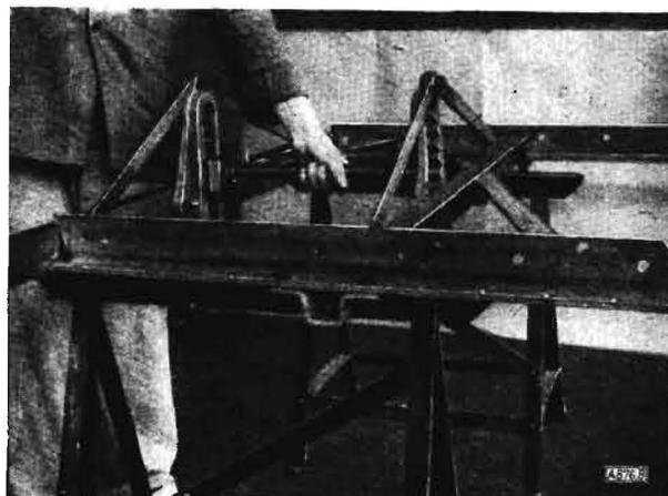
Bild 8. Prüfung des tolerierten Abstandes der Seitenträger für das Haupttrrad
