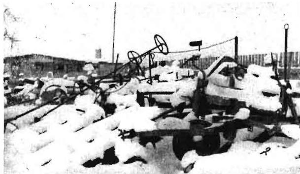
Bild 1 bis 3. Ohne ausreichenden Witterungsschutz sind Maschinen und Geräte der Korrosion ausgesetzt
