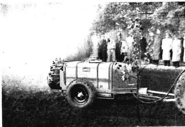
**Bild 5.** Die Weiterentwicklung des einfachen Sprühblasers führt zu Geräten mit mehreren starr angebrachten Sprührohren, die zu richten sind und je nach dem Verwendungszweck ausgewechselt werden können
