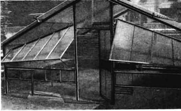
Bild 3. Giebeldreiecke als Schwingflügel ausgebildet
