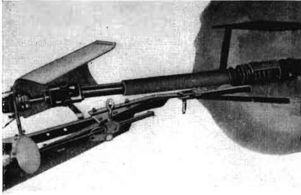
**Bild 1.** Gelenkwelle zur Leistungsübertragung vom Schlepper zur Arbeitsmaschine mit Schutzschildern (Bild: IHC)
