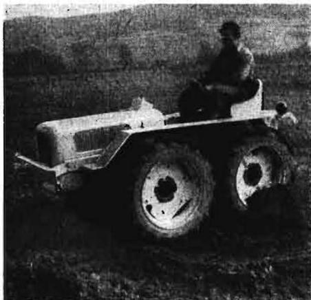
Bild 2. Allradantriebener Radschlepper mit „Raupe lenkung“ bei Fahrversuchen auf lockerem Fräsländ
