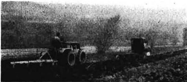
Bild 1. Eine Raupe mit Vierschar-Anhängepflug (Gewicht 6,5 t) und ein allradantriebener Schlepper mit Vierschar-Anbaupflug (Gewicht 3,7 t) im Vergleichseinsatz
