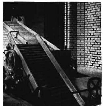
Bild 9. Kleineres Unterflur-entnahmeband in einem niederländischen Lagerhaus, das in die Boxe hineingeschoben wird
