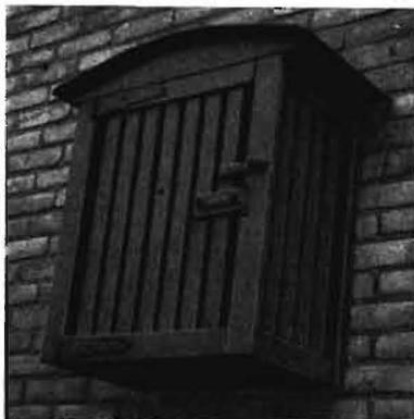
Bild 7. Unterbringung der außerhalb des Gebäudes befindlichen Teile der automatischen Steuerungsanlage
