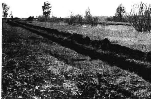
Bild 1. In Handarbeit ausgeführtes Verteilen des Grabenaushubs
