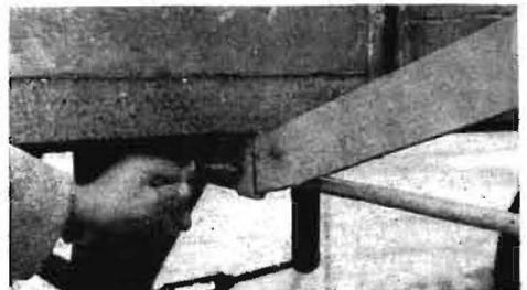
Bild 3. Die Konsolen werden durch einen Fallsplint gegen das Herausfallen aus den Taschen gesichert
