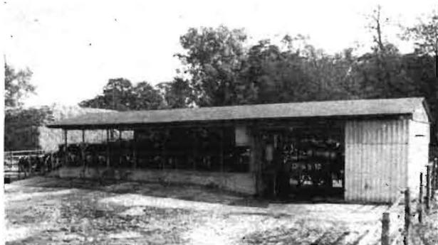
**Bild 1.** Kombiniertes Fischgrätenmelkstand für Stall und Weide, als stationärer Weidemelkstand im Institut für Landtechnik Potsdam-Bornim eingesetzt. Von links nach rechts: Vorwarte Hof, Melkplatz mit Triftgängen und Melkflur, Trennwand mit Rampe, Durchfahrt mit Milchtransportfahrzeug, Maschinenraum; an der Trennwand zur Durchfahrt sind die Milchkühler sowie der Spülflüssigkeitsbehälter, der Pulsverstärker und der Drucklöser für die automatische Ring-spülung montiert
