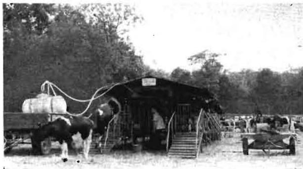
**Bild 2.** Die fahrbare Weidemelkstandausführung des kombinierten Fischgrätenmelkstands während des Erprobungseinsatzes in Bornim
