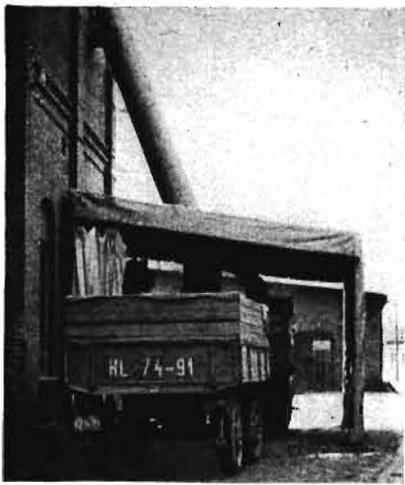
**Bild 4.** Das getrocknete Gut wird in der Zuckerfabrik Haldensleben lose über ein Fallrohr, das durch einen Schieber während des Anhängerwechsels verschlossen ist, abgegeben. Durch Schutzdach und schließbare Vorhänge ist ein guter Regen- und Windschutz gegeben
