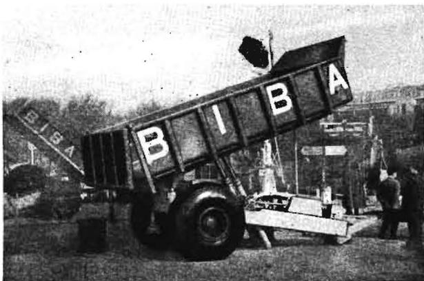
Bild 2. BIBA (Frankreich), Einachsenanhänger für 9 Mp Tragfähigkeit, Reibrollenrieb der Räder
