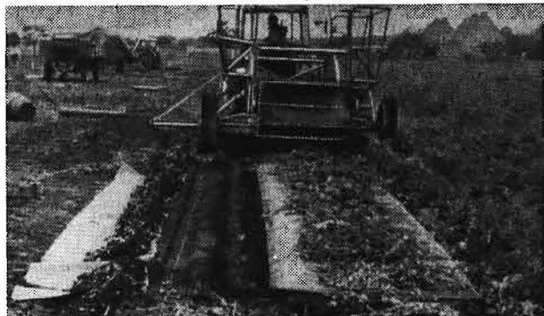
Bild 3. Arbeitsbild des Versuchsträgers. Die abgesiebten Fraktionen und der Siebüberlauf werden über eine Maßstrecke auf Tüchern aufgefangen
