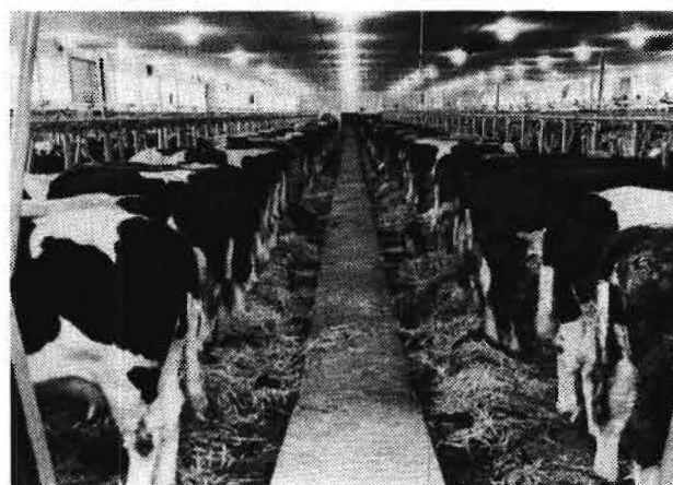
Bild 5. Entmistung mit Kratzerkette T 821 im umgebauten Rinderstall L 203 e
