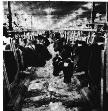
Bild 4. Verteilung des Futters mit Futterband im 2. umgebauten Stall der LPG Brunne
