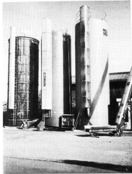
Bild 1. Versuchssilo aus glasfaserverstärktem Kunststoff (Mitte Wickelverfahren, rechts Schleuderverfahren) neben einem Holzsilos (links).
