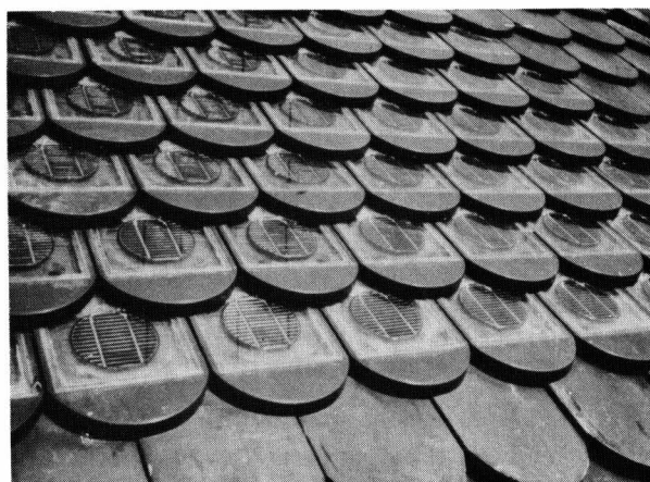
Bild 2. Dachziegel mit integrierten Solarzellen (Photo Stork).
