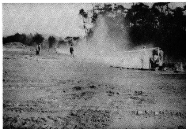
Bild 19. Breitstäubeverfahren mit Kunststoffolienschlauch.
