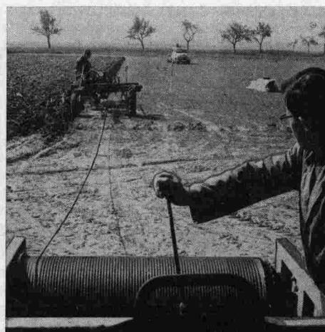
**Bild 33 bis 35.** Meßpflug zur Ermittlung des spezifischen Pflugwiderstandes.
