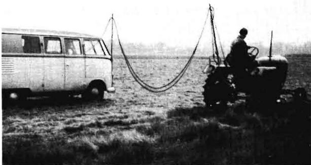
**Bild 16.** Bei den Probemessungen an einem Anbaumähwerk fuhr ein VW-Bus mit den elektrischen Registriergeräten neben dem Schlepper her.
