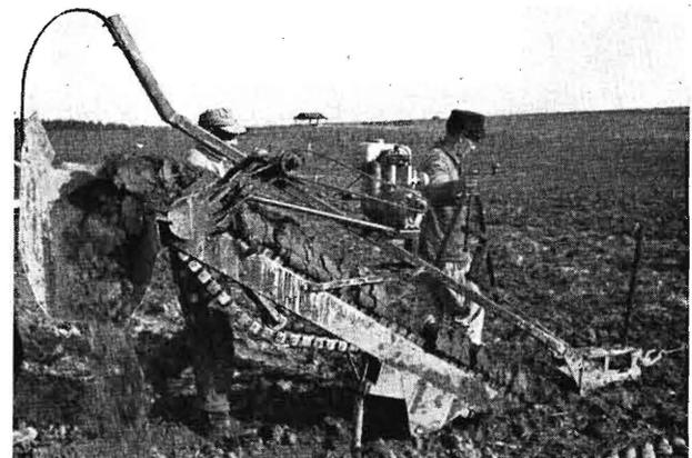
**Bild 11.** Umgebautes Aashamer-Drängerät mit Aufbaumotor und Gleitkufe. Dieses Gerät ist für wenig tragbare Böden geeignet.
