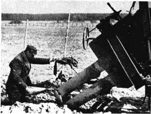
**Bild 3.** Einhängen der Eierkette am hochgeklappten „Maulwurf“ des Poppelsdorfer Drängerätes.
