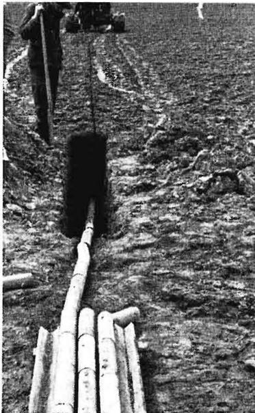
**Bild 2.** Einziehen des Rohrstranges in den Maulwurfsgang beim Poppelsdorfer Drängerät. Der Rohrstrang ist zu diesem Zweck auf eine „Eierkette“ aufgefädelt (rechtes Bild).
