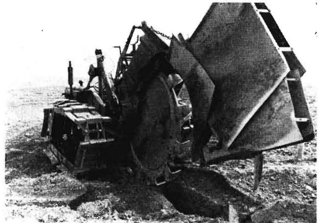
**Bild 15 und 16.** Fräsradbagger „Howard Trenchdigger“ der Firma Rotary Hoes, West Horndon, Essex, England, Arbeitstiefe 128 cm, Arbeitsbreite 20 bis 22 cm. Die Tonrohre werden über eine Rutsche halbautomatisch verlegt.
