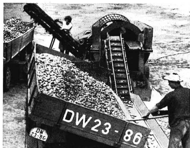
Bild 14. Flüssigkeitstrennanlage des Instituts für Landtechnik Potsdam-Bornim bei Einsätzen im Oderbruch.
