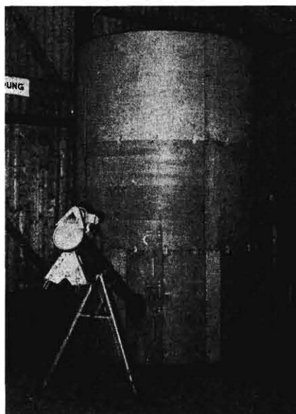
Bild 17. Sperrholzbehälter zur Getreidelagerung mit Förderschnecke zur Entleerung des ebenerdig aufgestellten Behälters.
