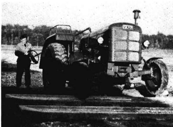
Bild 1. Marterstrecke für die Erprobung von Schleppern.
