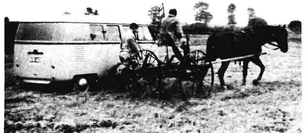
Bild 2. Messungen an Heuwendergabeln beim Wenden. Die elektrischen Registriergeräte sind in dem Volkswagenbus, der neben dem Versuchsgerät herfährt, untergebracht.
