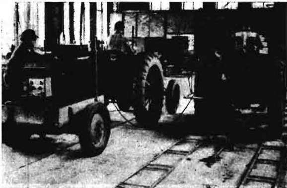
Abb. 15: Gesamte Maanordnung fr elektrische Schwingungsmessung am Schlepperfahrer
