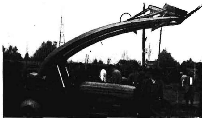
Abb. 17: Frontlader aus Blechpreßteilen geschweißt, als Träger gleicher Festigkeit
