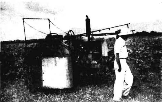
Abb. 1: „Low volume“-Spritzgerät am Schlepper mit Krautabweisern vor einem Baumwollfeld (Nicaragua)
