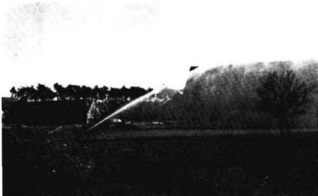
Abb. 23: Strahl aus einer Düse D 24/180°, Druck 7,5 atü
