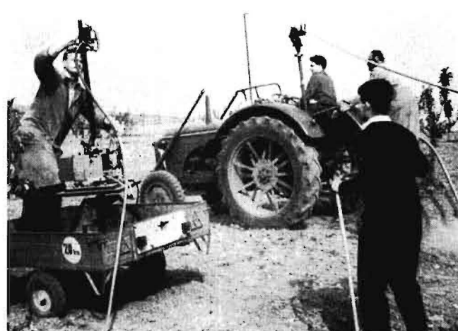
Bild 2: Lenkkraftmessungen auf lockerem Ackerboden
