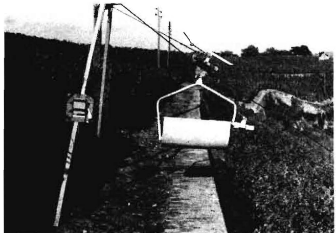
Bild 4: Funksender an einer Stütze für die Seilbahn montiert
