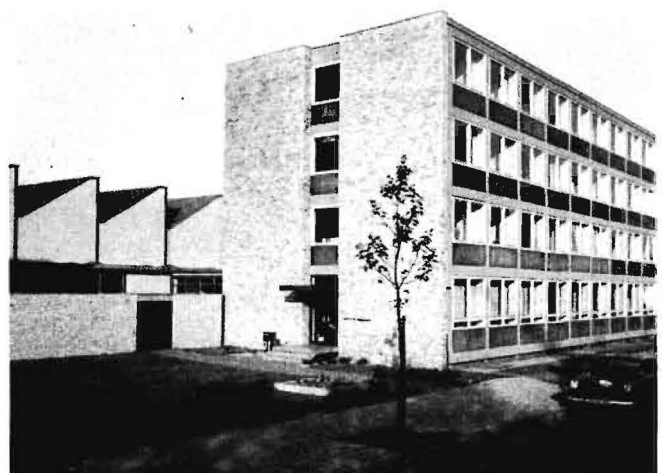
Bild 1: Straßenansicht des Bürogebäudes mit dahinterliegenden Versuchshallen
