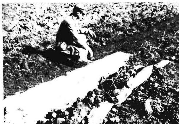
**Bild 2: Kontrolle der Siebleistung eines Vorratsroders mit untergelegter Plane**
