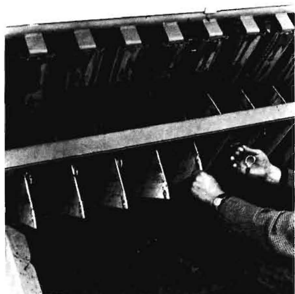
Bild 8: Rechenkette, Schneidvorrichtung mit feststehenden Messern, leicht ausschwenkbare Messer
