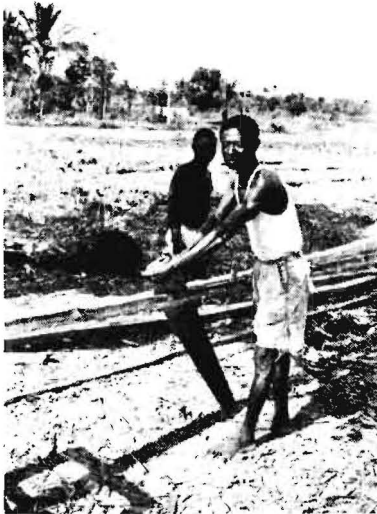
Bild 2: Mit dem Fuchsschwanz wird knochenhartes Teakholz gesägt
