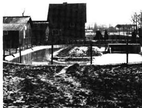
Bild 1: Oxydationsgraben mit Bürstenwalze (rechts) für die Aufbereitung von Flüssigmist aus einem Mastkälberstall
