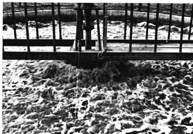
Bild 2: Das Bild veranschaulicht die starke Umwälzung durch einen Belüftungskreisel
