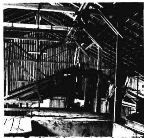
Bild 2: Laufkran bei der Entnahme von Silage Das Futter wird über eine gelenkige Fahrbahn in den Stall gebracht
