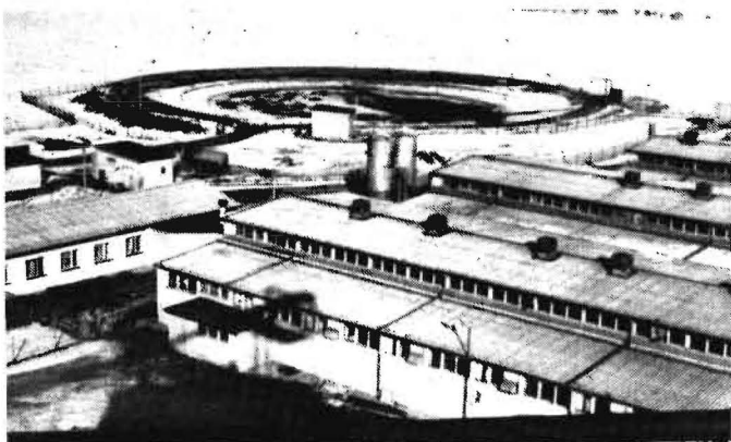
Bild 3. Ansicht des Güllelagerbehälters (Foto: M. Koallick)
