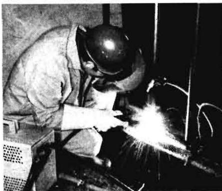
Bild 6. Vorschriftsmäßige Ausführung einer Schweißarbeit in einer belegten Stallanlage
