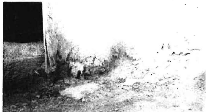
Bild 3. Zerstörtes Stützenfundament einer Holzleichtbauhalle infolge eines nicht ausreichenden Korrosionsschutzes
