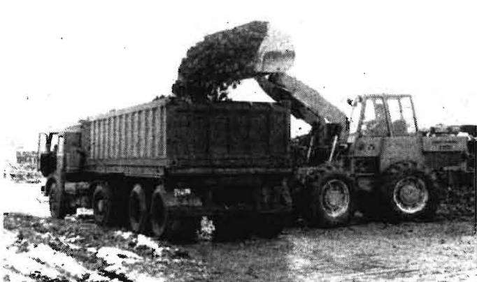
Bild 8. Zwischenlagerplatz mit Anschlußfahrbahn, befestigt mit Altreifengummimatten
