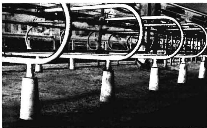
Bild 1 Betonelemente (Adapter) zur Aufnahme der raumstabilen und verspannten Standausrüstung
