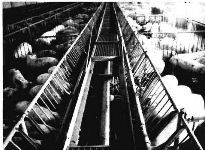
Bild 3. Platzsparende Aufstallung von Mastschweinen in Gruppenbuchten 005/006 mit stationärer Fließfütterverteilung
