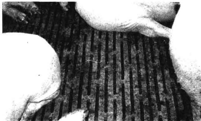
Bild 5. Graugußspaltenfußboden mit verringertem Materialaufwand im Einsatz in der Endmast; Blick auf den Kotplatz einer Gruppenbucht, Lebendmasse der Tiere rd. 100 kg
